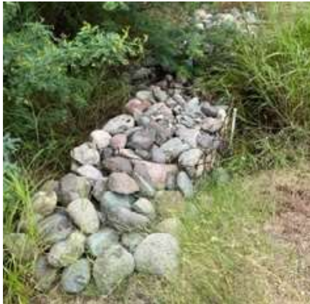
Ilustración 16. Acomodamiento de piedras para la conservación de suelo y agua- 2019.
